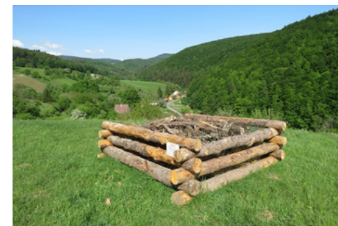
Obr. 8 Plazník se stěnami z kulatiny (foto: Jitka Větrovcová)
