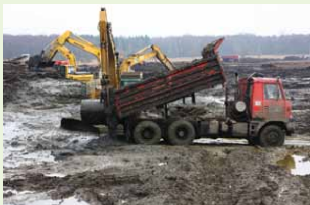
Transport řídkého sedimentu ze dna na mezideponii
