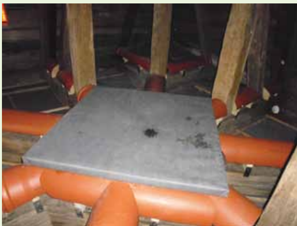
Ochrana očištěné trámové konstrukce a podlahy věže kostela v Heřmani z půlených PVC rour a paropropustné folie připevněné na dřevěném roštu
